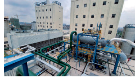
LE UNITÀ ORC DA 2.9 MWE REALIZZATE DA EXERGY IN CINA
