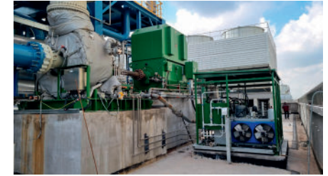
LE UNITÀ ORC DA 2.9 MWE REALIZZATE DA EXERGY IN CINA
